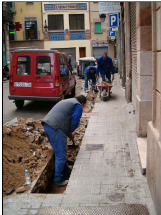
Fotografia núm. 7. Obrers treballant a la Rasa 200 (extracció del paviment actualment en ús i del sauló). Foto realitzada mirant al sud-est.
