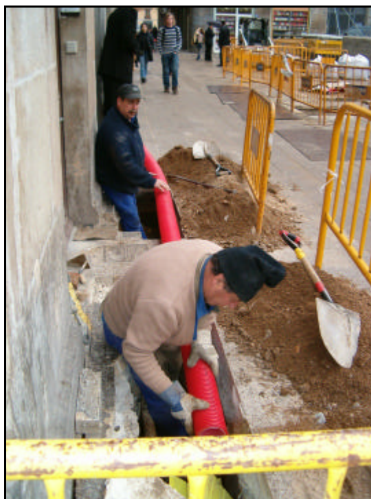
Fotografia núm. 5. Col·locació dels tubs per a cable elèctric a la Rasa 100, mirant cap al sud-oest.
