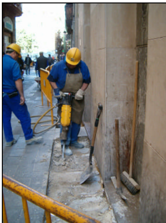
Fotografia núm. 2. Obrers treballant amb el martell compressor a la Rasa 100 (extracció del paviment actualment en ús i de la seva preparació de formigó). Fotografia efectuada mirant al nord-est.
