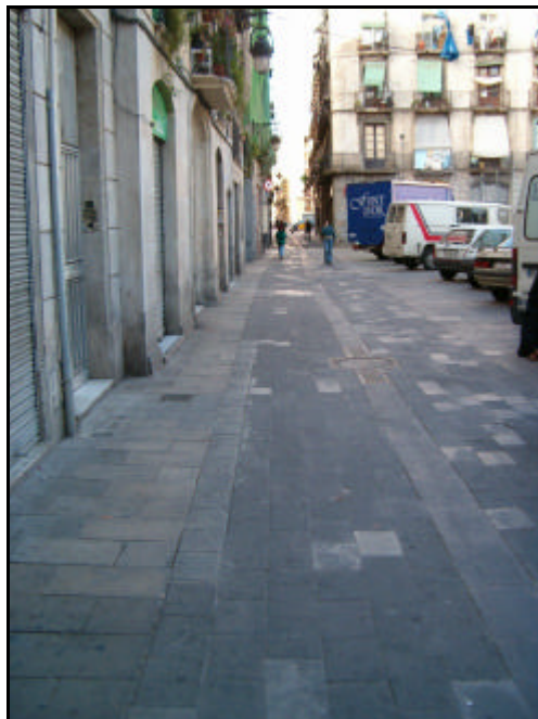
Fotografia núm. 1. Vista general de la zona on s'ha efectuat la Rasa 100 (Carrer de Sant Pau) mirant cap al sud-oest.
